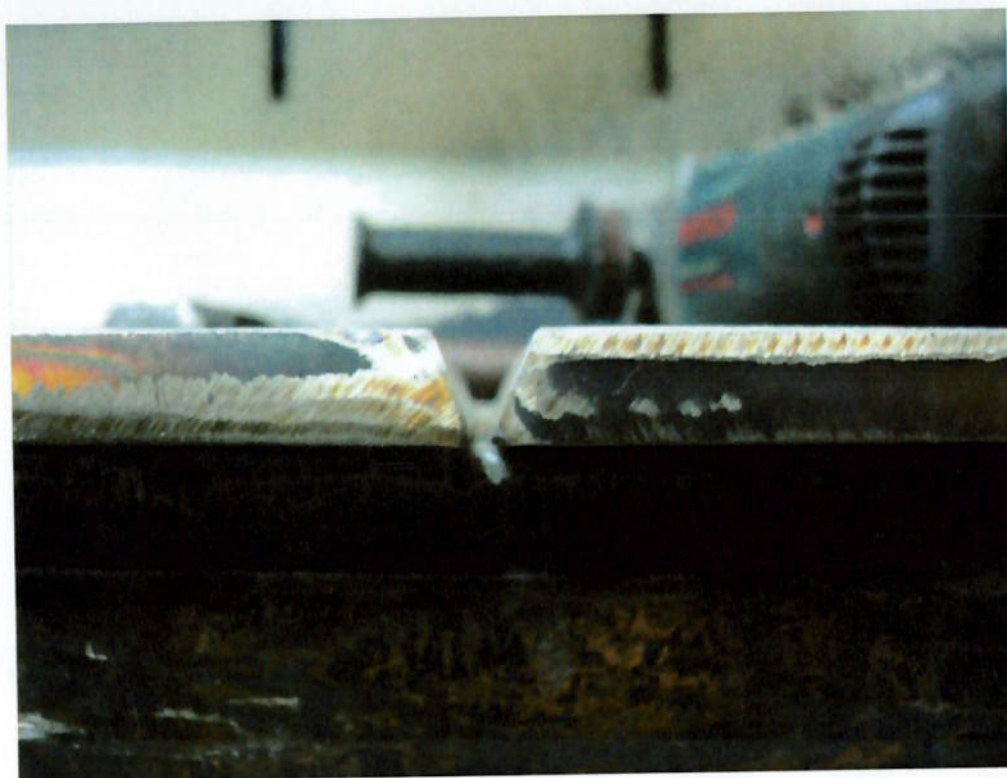
Figura 4.1.1 Junta preparada para a soldagem
